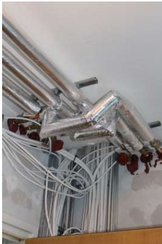
Sähkö ja vesijohtoasennuksia porrashuoneesta asuntoihin
