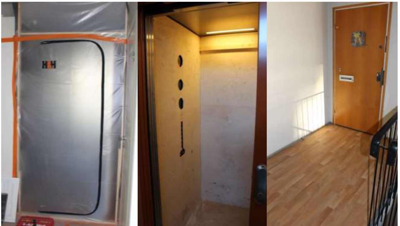
Asian mukainen suojaus ja kulkuväylän teko kuuluvat urakoitsijan vastuulle
