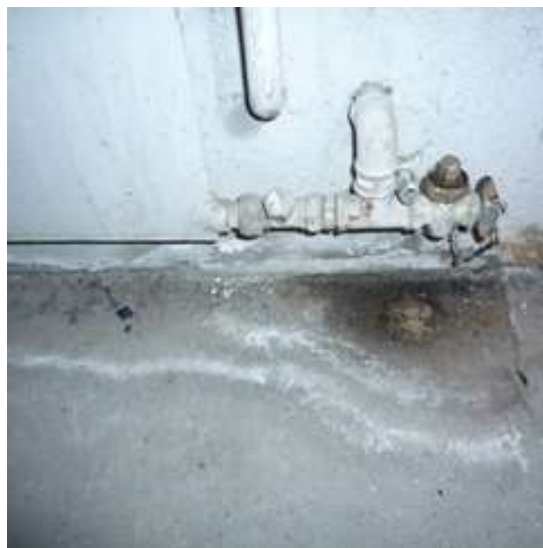
Korjaustyön aika on käsillä
