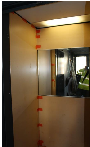
Kovalevyllä suojattu hissi.
