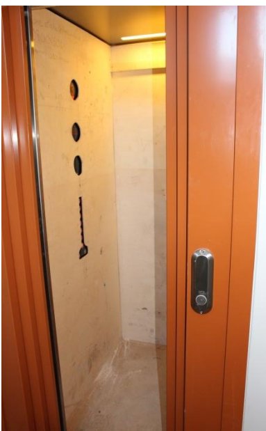
Vanerilla suojattu hissi.
